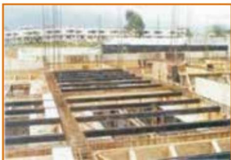
A. Apoyar los perfiles entrepiso sobre la formaleta de las vigas de la estructura principal, hasta que estos toquen los flejes de las vigas.
