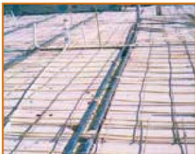
**Nota:** La malla electrosoldada debe quedar encima de las instalaciones para evitar fisuras en la placa.
