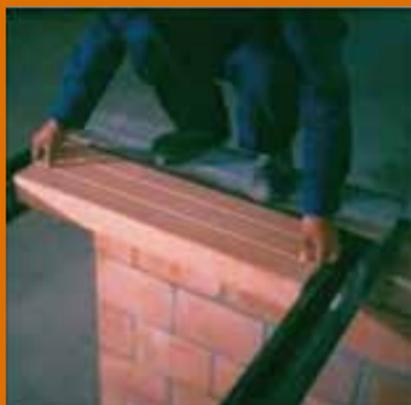
D. Colocar los bloquelones Santafé, apoyados en las aletas del Perfil Entrepiso, en los muros o en la formaleta de las vigas.
